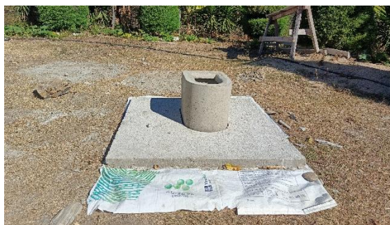
Ilustración 4. Taza y plancha listas para su instalación.
