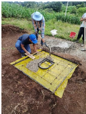
Ilustración 3. Preparación de mezcla de cemento para fundir taza y plancha.
