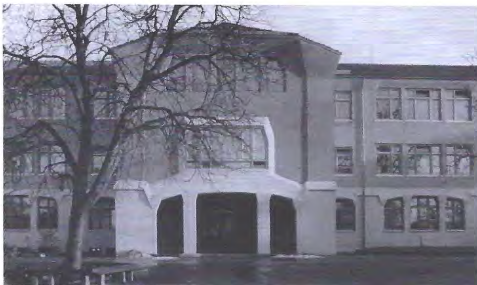
Freie Waldorfschule, Uhlandshöhe, Stuttgart, Germany
