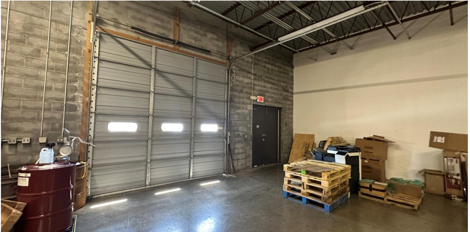
Loading Dock Door
